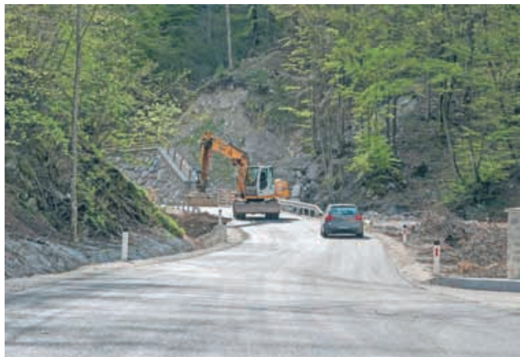
Obnova ceste v Davčo je že skoraj končana. / FOTO: ANDREJ TARFILA
